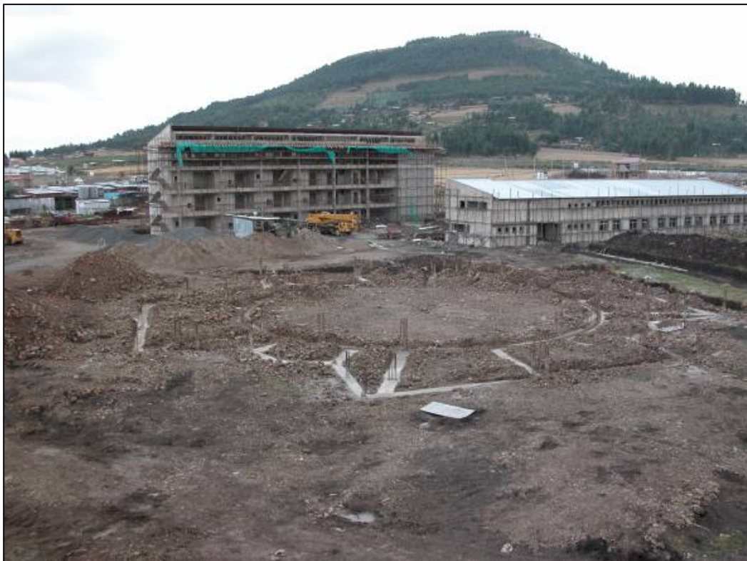
Multi Purpose Hall (D)
